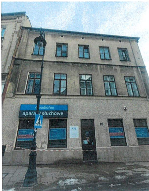
Fot. 1 Elewacja frontowa.
