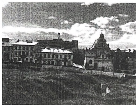
Fot. 2. Panorama widokowa zabytkowego zespołu urbanistycznego Starego Miasta i Śródmieścia Lublina – widok od strony ulicy Świętoduskiej (w zachodniej części pierzei widoczny frag. budynku mieszkaniowo-usługowego działki nr ewid. 24/3)
