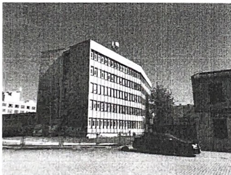
Fot.1. Budynek naukowo-dydaktyczny Instytutu Stomatologii posadowiony na działce nr ewid. 75/7 graniczący od wschodu z działką nr ewid. 24/3.
